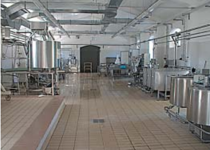
Foto 6 - Locale di lavorazione
